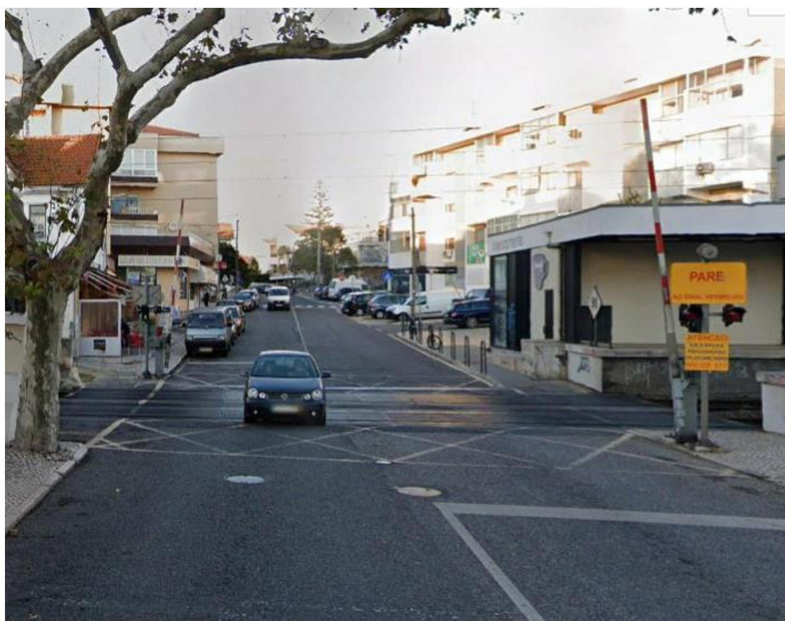
Figura 9 – Passagem de nível, podendo observar-se as marcas M8 – linha de paragem e M17b (“yellow box”), para além do dispositivo do sinal sonoro, o sinal S8 e a meia barreira listada de vermelho e branco.
